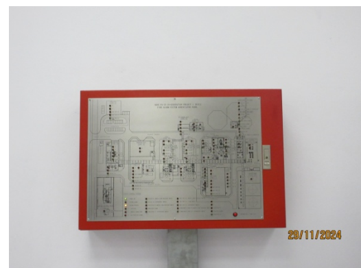
รูปที่ 30 Fire Alarm System
