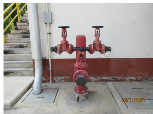
รูปที่ 48 Fire Hydrant
