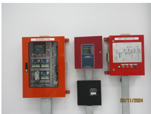
รูปที่ 29 Gas Detector System
