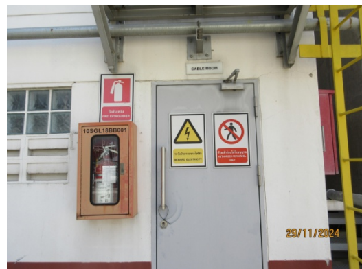
รูปที่ 52 Portable fire extinguishers
