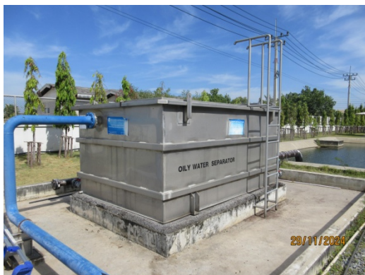
รูปที่ 13 ถังแยกน้ำ-น้ำมัน (Oil Separator)
