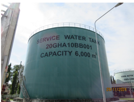
รูปที่ 47 ถังเก็บกักน้ำประปาขนาด 6,000 ลูกบาศก์เมตร
