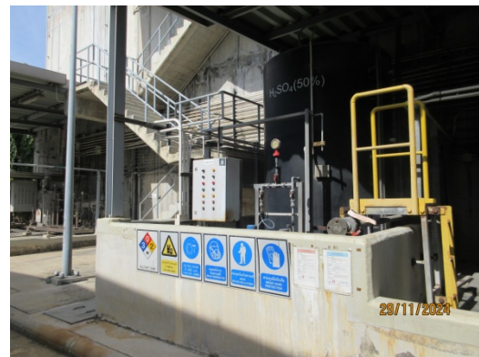
รูปที่ 55 ถังเก็บน้ำและสารเคมี
