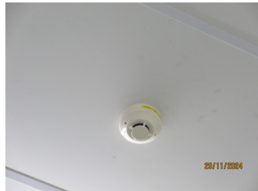
รูปที่ 32 Smoke Detectors
