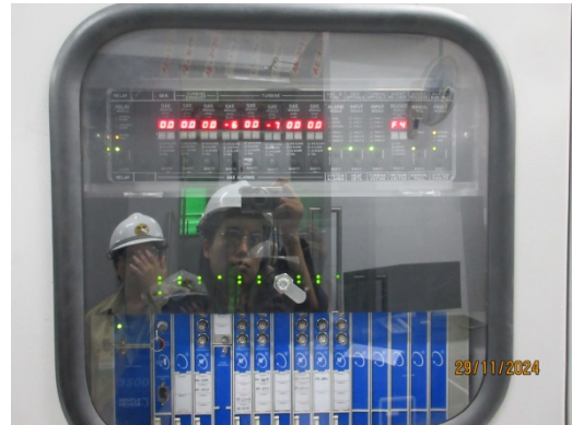
รูปที่ 44 Gas Detector บริเวณ Gas Turbine และ Gas Compressor
