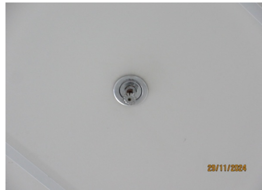
รูปที่ 34 Sprinkler System
