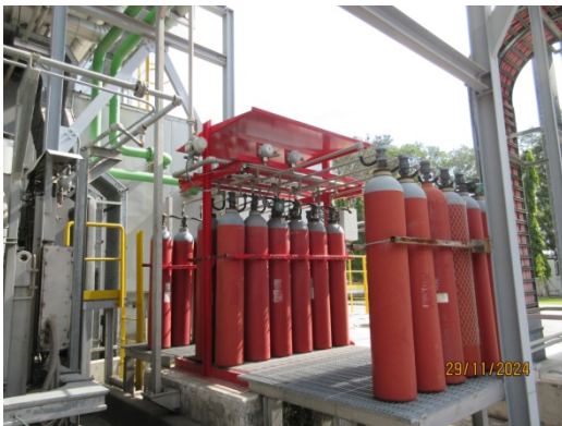
รูปที่ 45 ระบบดับเพลิงแบบใช้ CO 2
