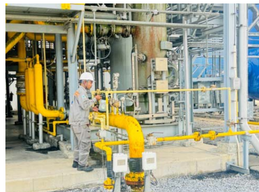
รูปที่ 57 ตรวจสอบการรั่วซึมของระบบท่อ
